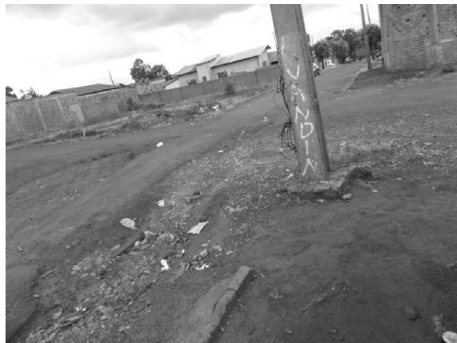
Figura 3. Ausência de calçada e pavimentação no trajeto P1. Novembro a dezembro de 2015. Tangará da Serra -MT, Brasil.
